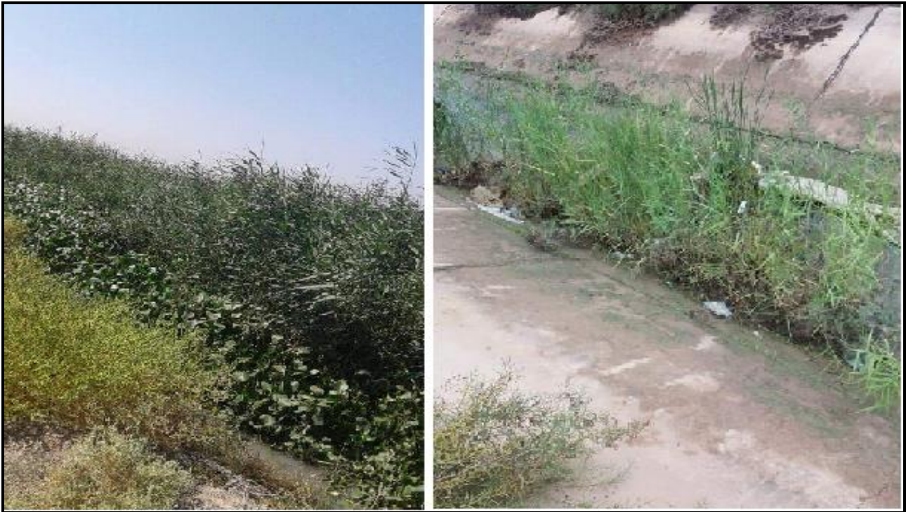
صورة (٢) نمو القصب والبردي وزهرة النيل في الجداول المبطنة والترابية (غير المبطنة)
